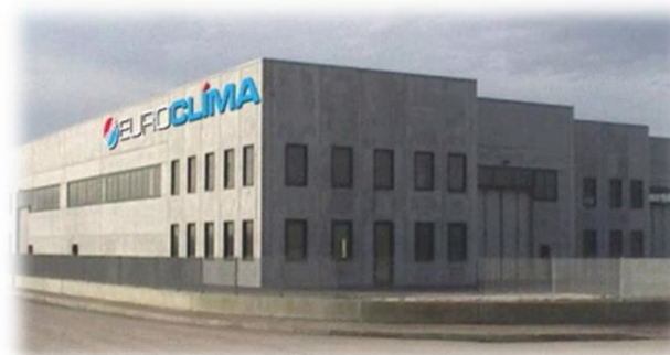
Αποθηκευτικοί Χώροι Mellarredo (VE), Ιταλία
