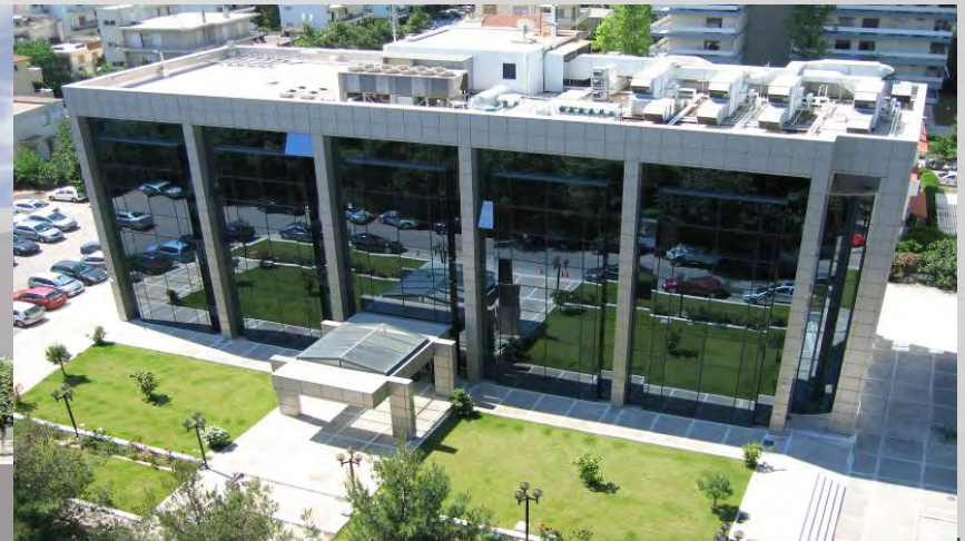
Κτίριο γραφείων (Χαλάνδρι, Αθήνα)
